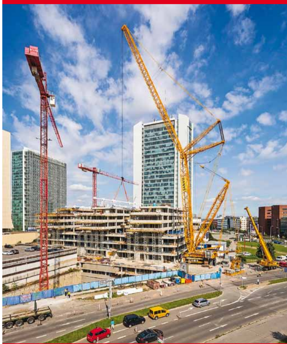
Nad konferenčním centrem na Pankráci v těsné blízkosti frekventované pražské magistráty osazovali v srpnu montéři z provozu ocelových konstrukcí divize 3 nosníky, svislice a táhla na střechu rozestavěné budovy City Deco. Jednotlivé dílce s hmotností až 46 tun museli zvednout do výšky 45 m a uložit do vzdálenosti více než 90 m. Použili k tomu největší pásový jeřáb u nás – Liebherr LR 1750, jehož umístění v husté zástavbě bylo velmi složité stejně jako všechny manipulace, které s jeho pomocí prováděli. Další informace najdete na straně 2.
