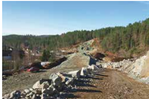
Pohled k východnímu portálu tunelu Moane, který bude měřit 350 m a bude mít profil 130 m 2 stejně jako druhý, o 150 m delší tunel Vollås
