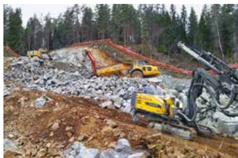
Stroje partnerské firmy Bertelsen & Garpestad před portálem zahájily zemní, v tomto případě spíš skalní práce
