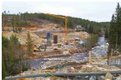
Před západním portálem tunelu Moane staví most Sagrenda druhý partner ve sdružení, firma HAG Anlegg
