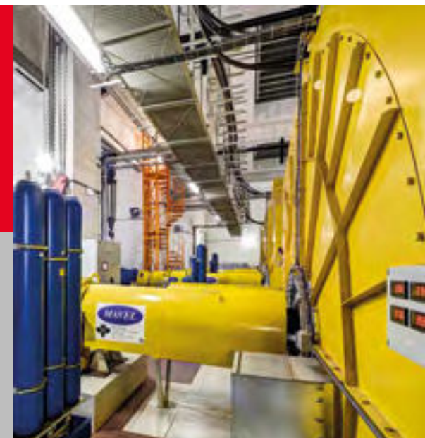
Rekonstrukce malé vodní elektrárny Štvanice Reconstruction of the small water plant on Štvanice
