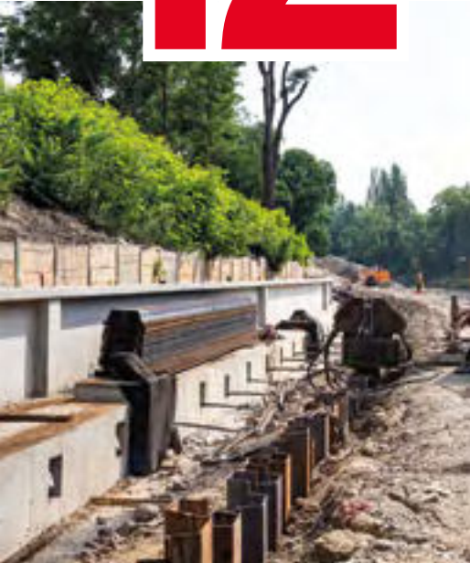
Zajištění projektu rekonstrukce plavební komory Štvanice Foundation of the lock dam on Štvanice in Prague
