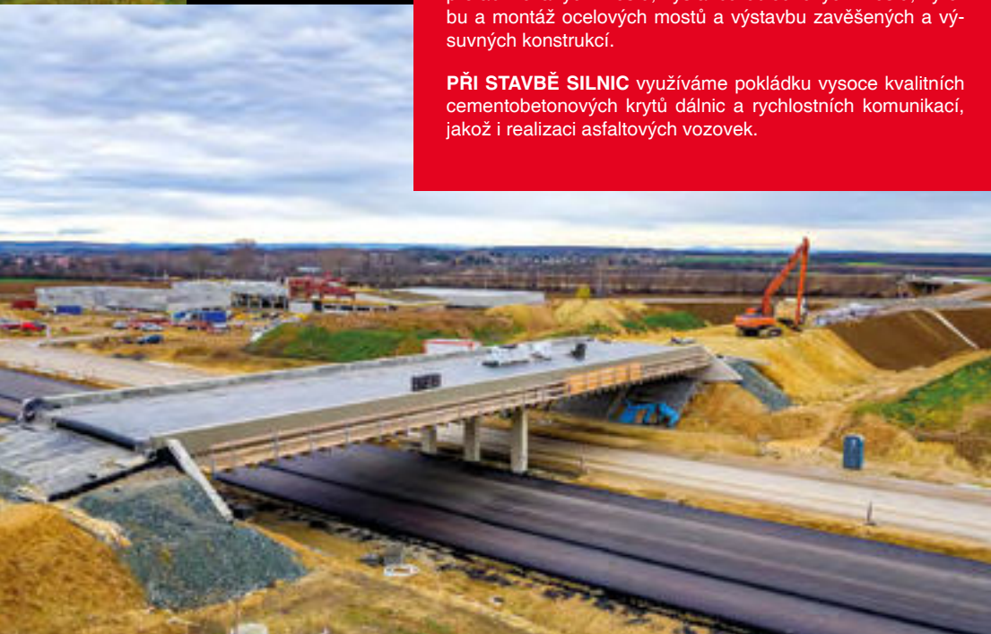
Výstavba 3. a 4. etapy dálnice M85 v úseku Sopron–Nagylózs Construction of 3. and 4. stage of M85 highway from Sopron to Nagylózs
