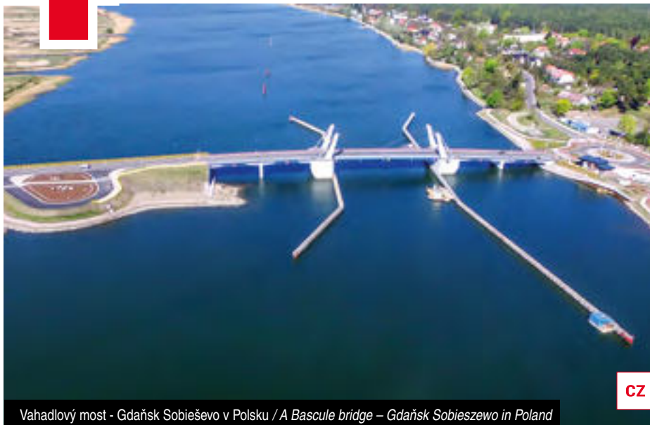
Vahadlový most - Gdaňsk Sobieševo v Polsku / A Bascule bridge – Gdaňsk Sobieszewo in Poland
