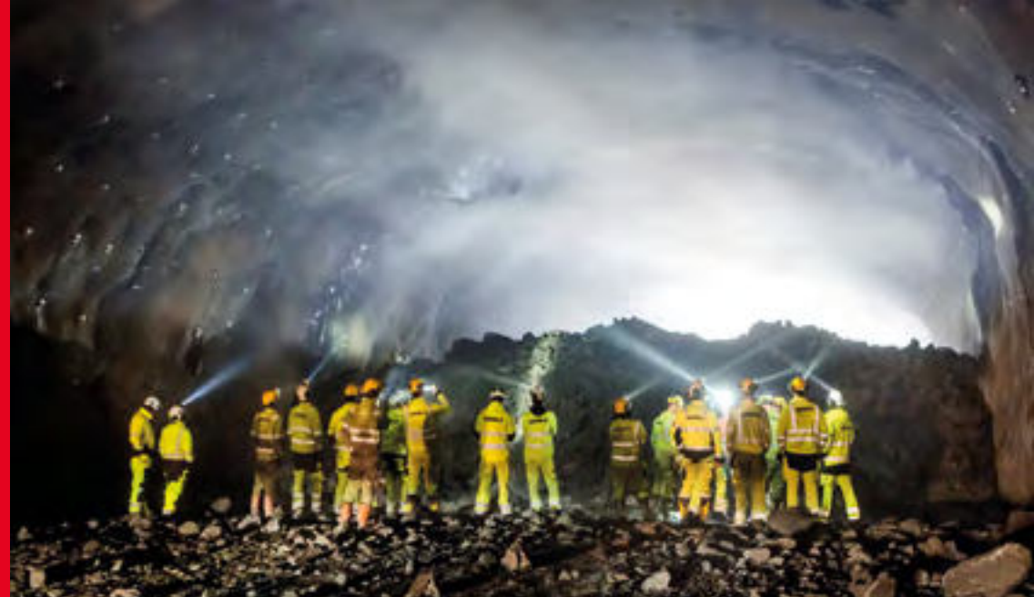
Prorážka dálničního tunelu Skärholmen ve Stockholmu, Švédsko / Breakthrough of the Skärholmen Tunnel in Stockholm, Sweden
