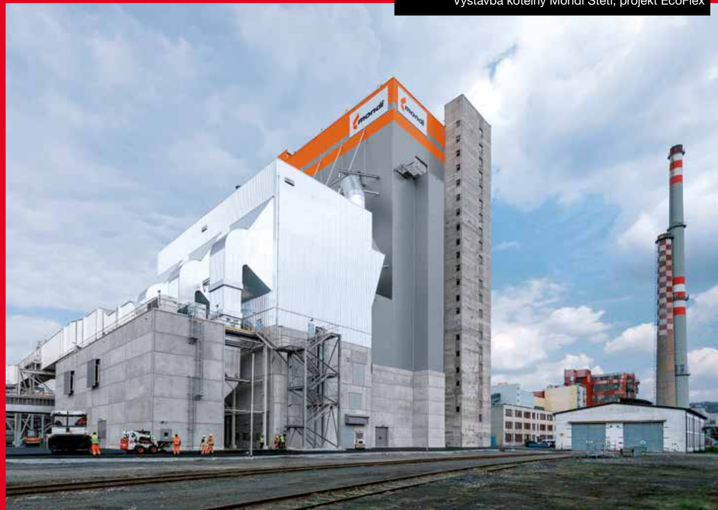
Výstavba kotelny Mondi Štětí, projekt EcoFlex
