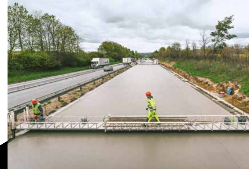
Modernizace dálnice D1, úsek 06, Psáře–Soutice
